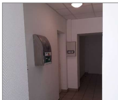
Dans le couloir sous la mairie
